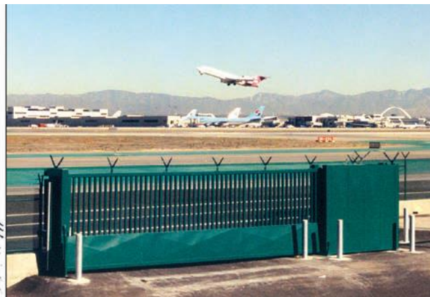
Мөргөлтөд тэсвэртэй автомашины хаалт
