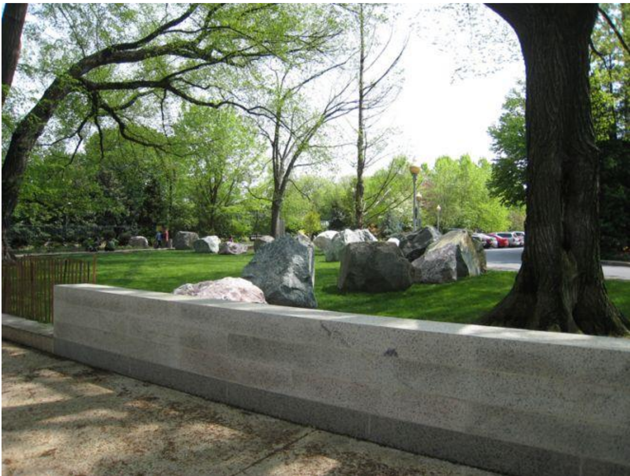
Байгалийн чулуу, хашлага ашиглан хаалт хийсэн байдал
